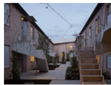
青木 淳 AOKI Jun 建築 Architecture 「青々荘」2010 "Maison AoAo", 2010 photo: 阿野大一 Daici Aino
