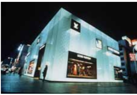
ルイ・ヴィトン 名古屋栄店 撮影: 青木淳建築計画事務所
